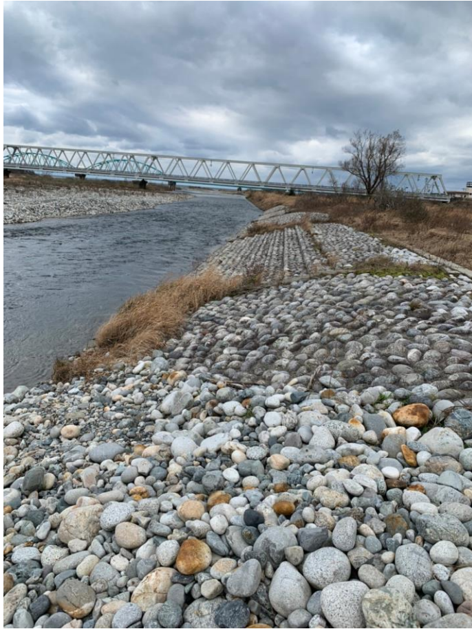
②黒部川右岸 1.0k 付近 (延長約 100m)
