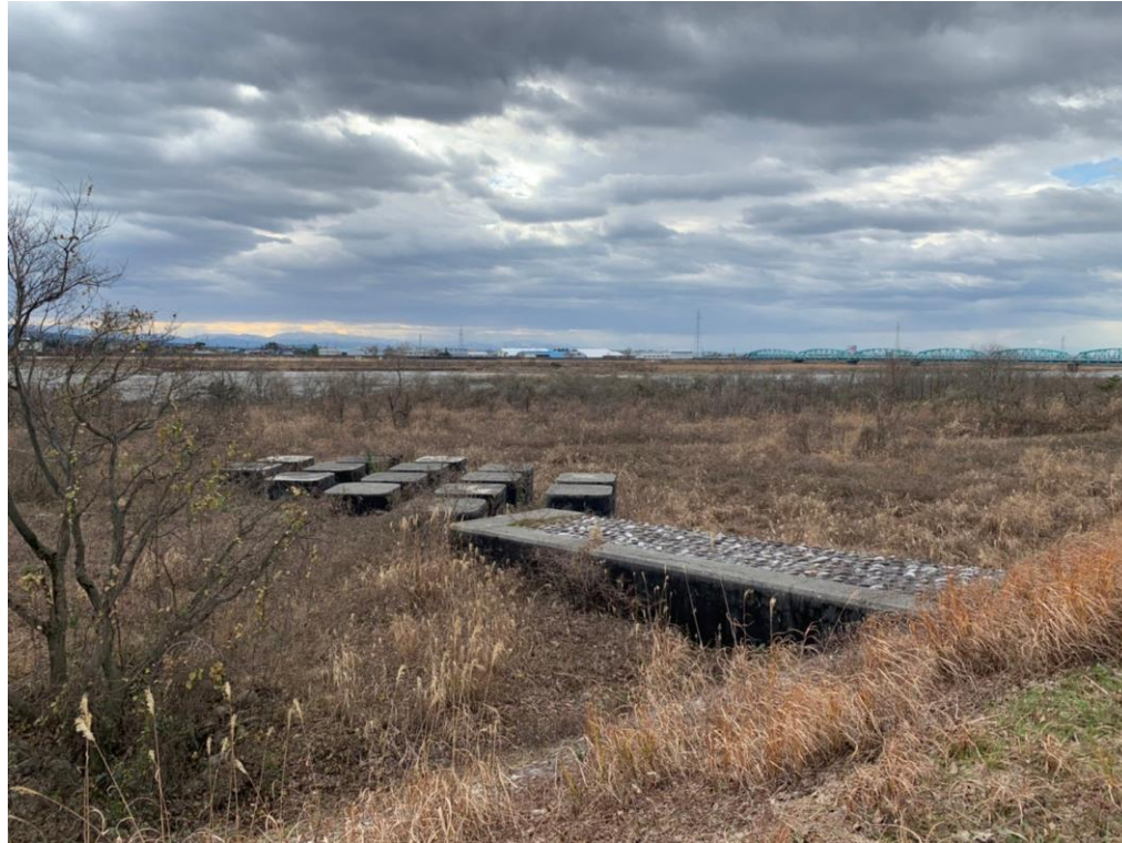
①黒部川右岸 7.6k 付近 (延長約 50m)
