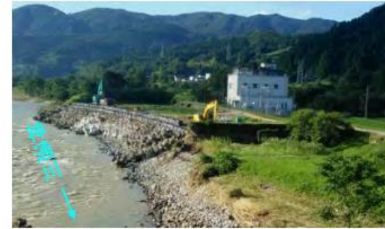
復旧状況 (平成30年7月10日 7時00分)
