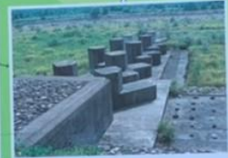
巨大水制群 (きょだいすいせいぐん) 洪水から川岸や堤防を守るために、水の流れる方向を変えたり、水の勢いを弱くするために置かれるものです。
