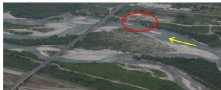
増水前の状況 (平成 25 年 6 月 13 日)
