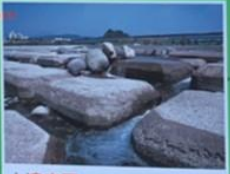
上滝床固 (かみたきとこがため) 洪水で河原が削られるのを防ぐ、川の勾配一定に保つた工事されました。コンクリートを使用した十字型ブロックの橋脚は常願寺川で生まれました。
